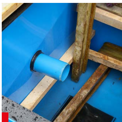
16. Fertiges Ablaufrohr mit Dichtung in der integrierten Muffe
