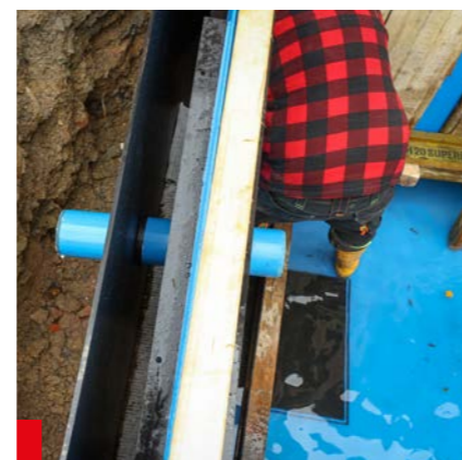
15. Positionierung des Ablaufrohres über dem Pumpenpodest
