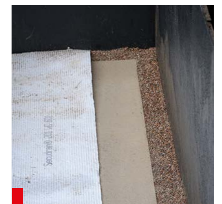
09. Einbau der Kies-/Splitüberdeckung über dem Leckagerohrsystem
