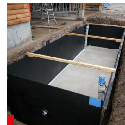
08. Fertige Betonbodenplatte
