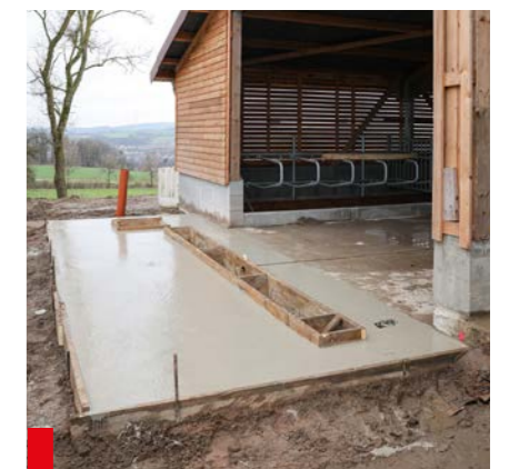
24. Fertig betonierte Abdeckplatte
