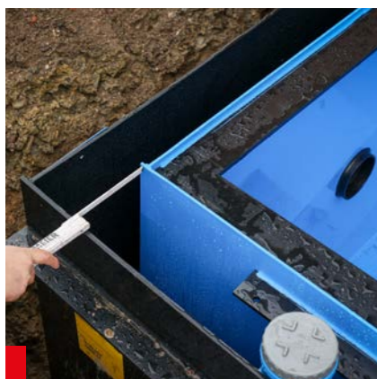
13. Ausrichten des Innenbehälters
