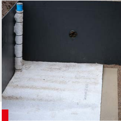
10. Vollflächiges Auslegen des Geotextils
