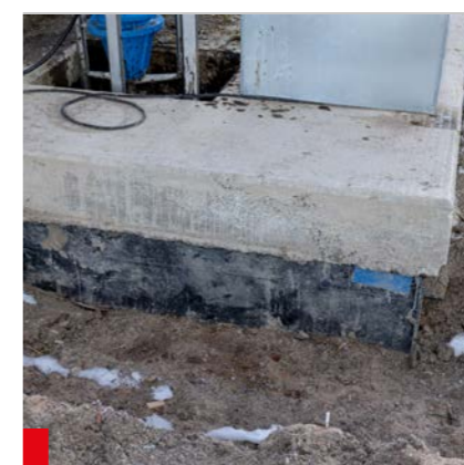
26. Seitliche Ansicht der Betonabdeckung
