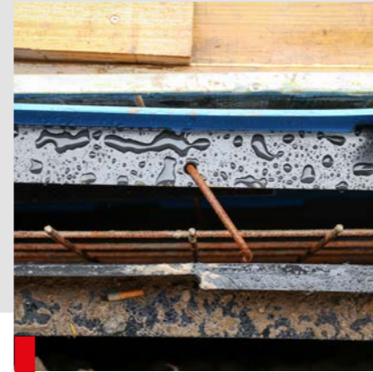
19. Fertiggestellte Armierung
