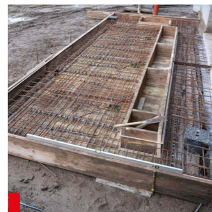
22. Schalen und Armieren der Abdeckplatte
