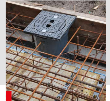
21. Positionierung der Gussabdeckung für die Leckageüberwachung
