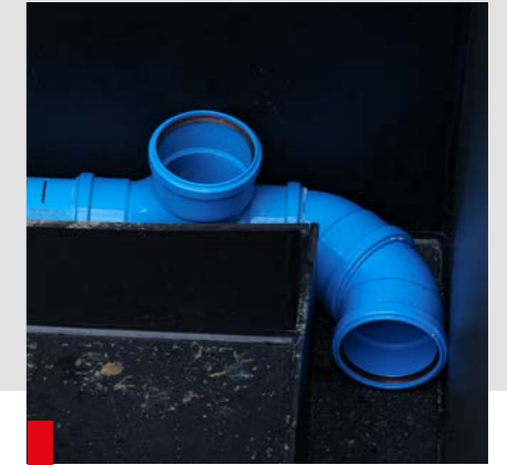
03. Einbau der Rohre für die Leckageüberwachung
