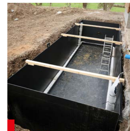
05. Ummantlung des Leckagerohrsystems mit Geotextil
