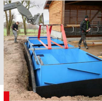
12. Einsetzen des Innenbehälters
