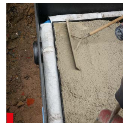
07. Einfüllen des Betons
