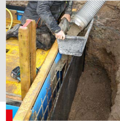
20. Lagenweises Einbringen des Betons und des äußeren Bodens
