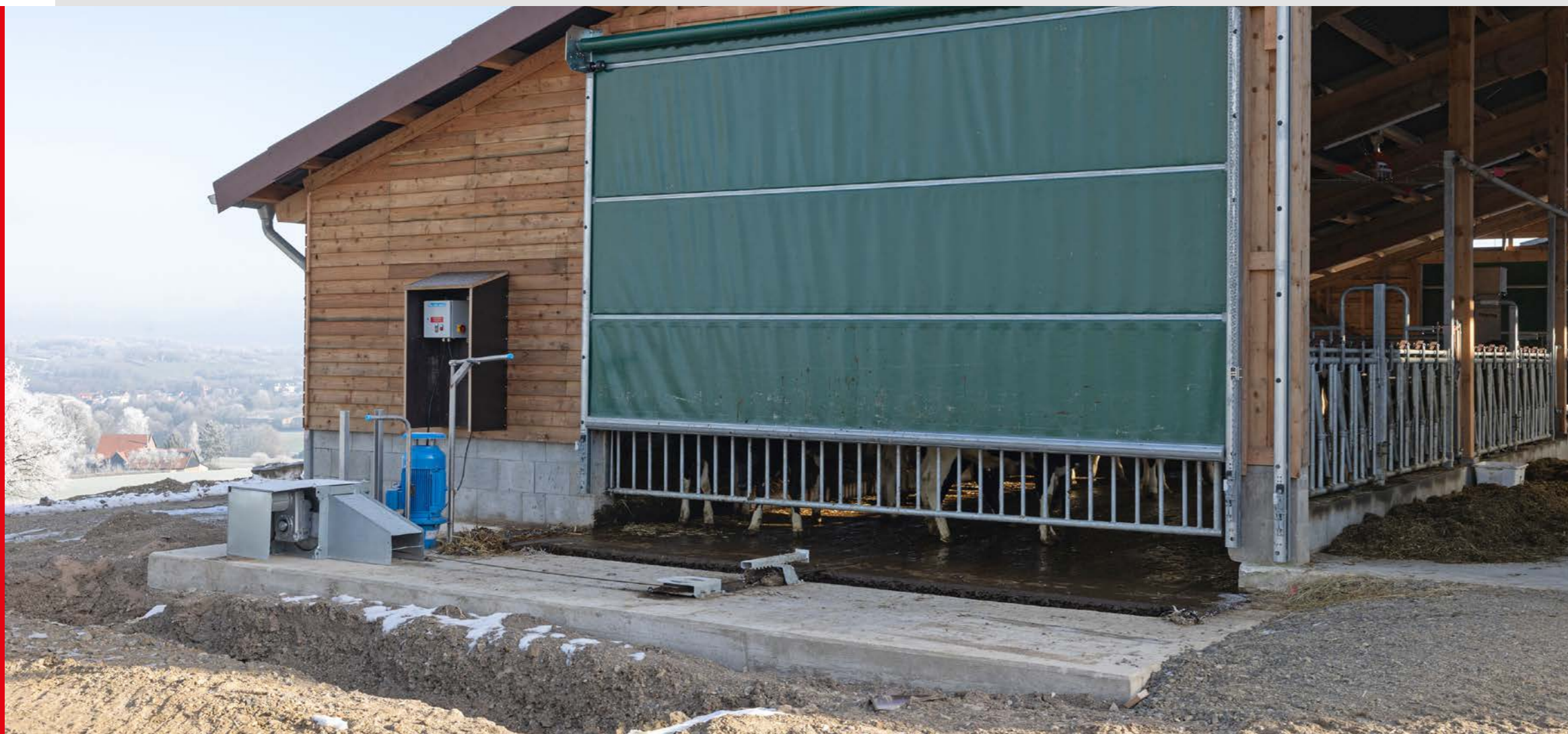
Fertiger Funke JGS®-Pumpenschacht mit einer Länge von 7 m und einer Höhe von 1,70 m.
