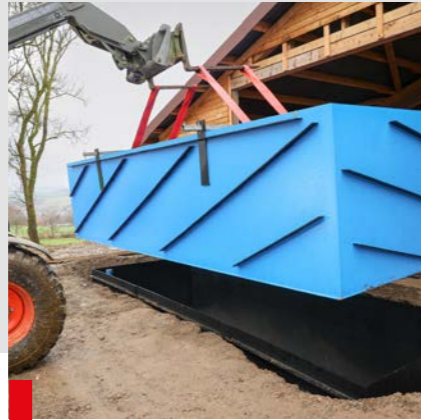
11. Einsetzen des Innenbehälters
