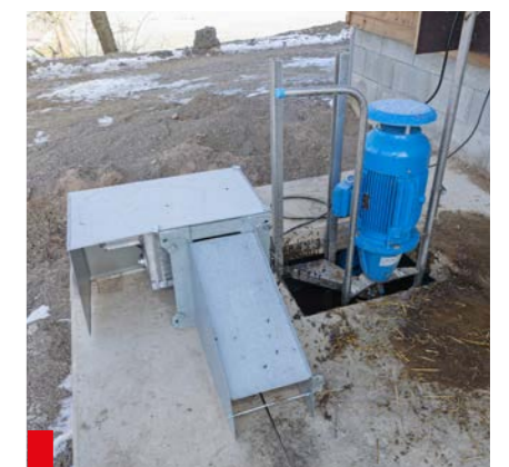
27. Installation von Pumpentechnik, Rührwerk und Schlitten
