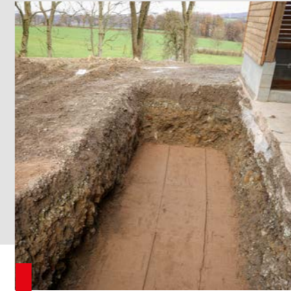
01. Erstellen des Planums
