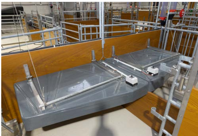
Der Schalter zur Temperaturregulation der Infrarot-Wärmeplatte wird auf der Oberseite der Ferkelnest-Abdeckung montiert
