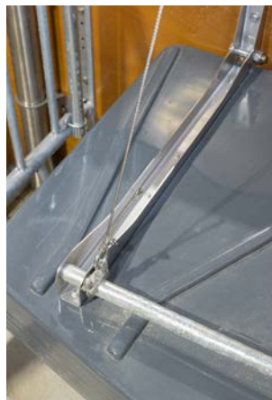
Befestigung vor Ort mit Scharnieren und Drahtseilen
