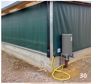
Der fertige Stall mit Aufnahme für den Spülschacht. (30)
