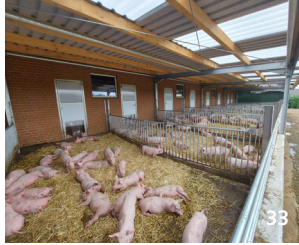
Der fertige Stall in der Nutzung. (33)
