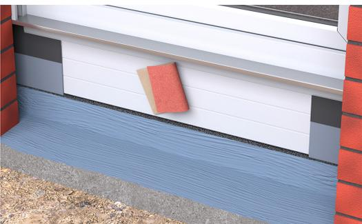
**Weitere Abdichtung mit FPD:** Vervollständigung der außenliegenden Bauwerksabdichtung mit FPD (flexible polymermodifizierte Dickbeschichtung): Oberflächen von Blendrahmen/Bodeneinstandsprofil und Fensterecke von grobem Schmutz reinigen, entfetten, anschleifen und Schleifstaub entfernen.
