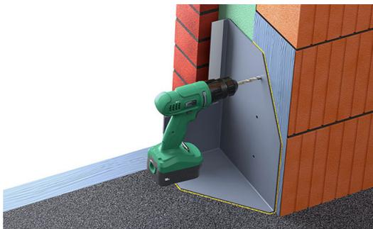
Bei tragenden Innenschalen aus Beton oder Mauerwerk: Drei Bohrungen Durchmesser 8 mm lotrecht in einem Abstand von ca. 5,0 cm von der Außenseite der Innenschale herstellen sowie eine Bohrung in die Aufstandsfläche der Fensterecke. Um später einen festen Sitz der Funke Fensterecke an der Laibung der Innenschale zu gewährleisten.
