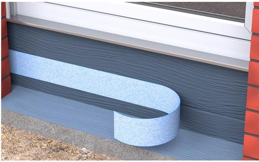
Vervollständigung der außenliegenden Sockelabdichtung mit FPD (z.B. Remmers MB 2K): Auftrag der Sockelabdichtung aus FPD in zwei Arbeitsgängen. Die Fuge beim Materialwechsel Blendrahmen/Untergrund wird mit beidseitig vlieskaschiertem Fugenband (Produkt: z.B. Remmers Tape VF 120) verstärkt. Das Band liegt mittig in der Abdichtungsschicht. Die Mindestrockenschichtdicke sollte 3 mm betragen. Entsprechend den jeweiligen Herstellerangaben.
