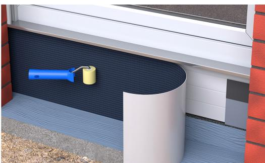
Vervollständigung mit der Funke SK-Dichtbahn mit vollflächiger Selbstklebeschicht: Die rückseitige Schutzfolie ist schrittweise je nach Verklebungsvorgang von der Funke SK-Dichtbahn abzuziehen. Funke SK-Dichtbahn vollflächig aufkleben und mit einem geeigneten Werkzeug (Andrückrolle bei Funke Kunststoffe GmbH zu beziehen) fest und blasenfrei anrollen.
