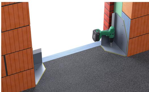
Es empfiehlt sich, die Fensterecke fest in die Ecke zu drücken und die senkrechte Bohrung in die Bodenplatte auszuführen.
