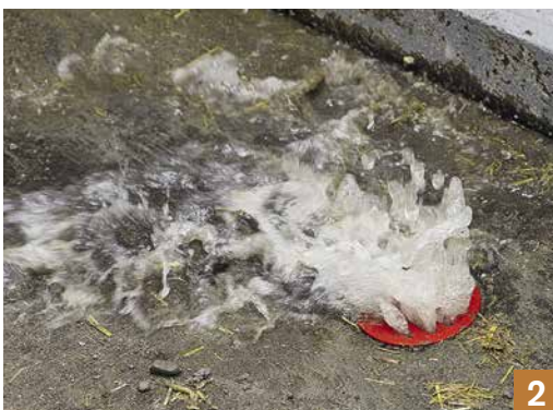
△ 1) Durch die roten Rinnendeckel fließt Jauche in die PVC-Rohre. 2) Nach jedem Entmisten werden die Leitungen mit einem Wasserschwall gereinigt. 3) Dieser entsteht durch das Ablassen angestauten Wassers aus einem 1,4 m höher angebrachten Spülschacht.
