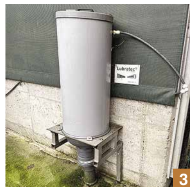
△ 1) Durch die roten Rinnendeckel fließt Jauche in die PVC-Rohre. 2) Nach jedem Entmisten werden die Leitungen mit einem Wasserschwall gereinigt. 3) Dieser entsteht durch das Ablassen angestauten Wassers aus einem 1,4 m höher angebrachten Spülschacht.
