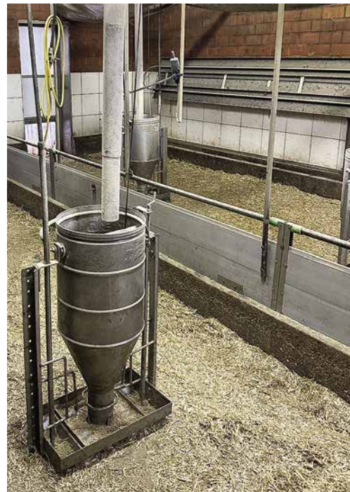
△ Die Abteile im Stallinneren sind erhalten geblieben. Sie wurden lediglich auf Güllekellerniveau abgesenkt.
