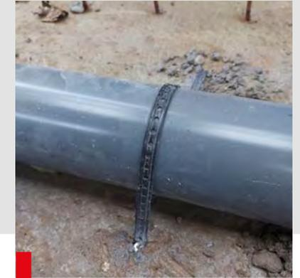
03. Um einen Auftrieb beim Betonieren zu verhindern empfiehlt es sich, die Funke JGS®-Rinne gegen Auftrieb zu sichern.
