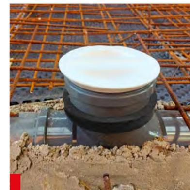
04. Vor dem Betonieren sind die JGS®-Betonstopfen mit dem Pfeil in die spätere Fließrichtung zu positionieren.
