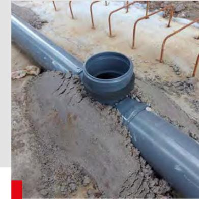
02. Beim Ausrichten empfiehlt es sich, Betonstützen im Zwickelbereich des Rohres und an den Rinnenabläufen anzubringen.
