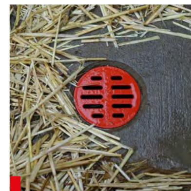
07. Die Schlitzanordnung im Abschlußdeckel sorgt dafür, dass Stroh weitestgehend zurückgehalten wird.
