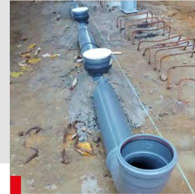
01. Die Jauche-Rinne wird komplett in Beton eingebaut. Schnur, Aluschiene und Wasserwaage helfen beim Ausrichten.
