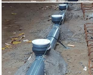
Die Leitung ist in Waage zu legen. Als Hilfsmittel können ein Niveliergerät, Schnur, Wasserwaage, Laser, etc. dienen. (4)
