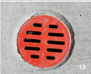
JGS-Betonschalungsstopfen in der ausgehärteten Bodenplatte. (17)
