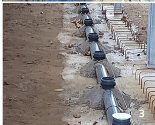
Zum einfachen Ausrichten hat es sich bewährt, Betonstützen vor Ort im Zwickelbereich des Rohres bzw. den Abläufen anzufügen. (3/6)
