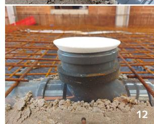
Vor dem Betonieren sind die JGS-Betonschalstopfen so in die Muffe einzufügen, dass die Oberkante waagrecht ist. Die Swept Seite (45°) zeigt immer in Fließrichtung. (12)
