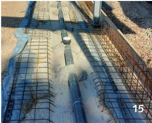
Bitte den Betonschalstopfen in Fließrichtung in die Muffe setzen. Der Pfeil muss in Fließrichtung zeigen. Eine zusätzliche Fixierung ist nicht erforderlich. (13)
