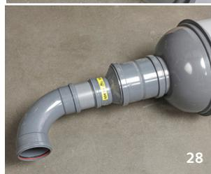
Die oben genannten Bauteile werden unter Verwendung von Gleitmittel zusammengesteckt und mit dem Langbogen 87° Muffe-Muffe am Anfang der Rinne verbunden. (28)
