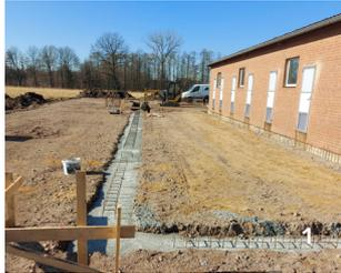
Die JGS-Rinne muss komplett gemäß DWA-Regelwerk A792 bzw. den örtlichen Anforderungen in Beton eingebaut sein. Entsprechend der DIN 11622-2:2015 und DIN 11622-5:2015 (1)
