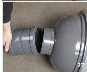
Anschließend wird die Dichtung der Doppelmuffe mit Gleitmittel eingestrichen und die Doppelmuffe auf das Spitzende des Spülschachtes geschoben. (27)
