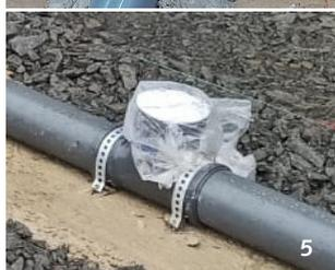
Wenn nach dem Setzen der Rinneneinläufe nicht unmittelbar betoniert wird, sollte der Rinnenablauf bzw. die Quellschichtung vor Regen geschützt werden. (hierzu die Verpackungsfolie überstülpen S. Bild 5)
