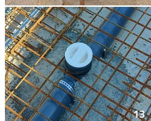
Eine Betondeckung der Bewehrung von min. 45mm zur Oberfläche und min. 25mm
