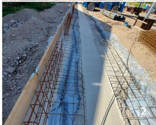
Die JGS-Rinne ist auf eine Sauberkeitsschicht aus Beton bzw. auf die untere Bewehrungslage ohne Gefälle (in Waage) auszurichten. (2)
