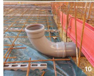
Die Positionierung ist vor Ort frei wählbar. Es sollte jedoch berücksichtigt werden, dass dort der 400er/630er JGS-Spülschacht aufgesetzt werden muss.
