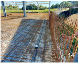
auf der Unterseite ist einzuhalten. Wichtig ist die Betondeckung von 25mm auch zu allen Teilen der JGS-Rinne einhalten werden muss.
