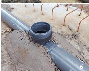
Um einen Auftrieb beim Betonieren zu verhindern empfiehlt es sich die JGS-Rinne, wie im Bild zu sehen, gegen Auftrieb zu sichern. (3/4/5/6)
