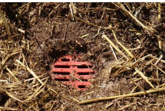
Die geschlitzten Rinnenablaufdeckel und Rinnenabläufe sind im eingebauten Zustand befahrbar.
