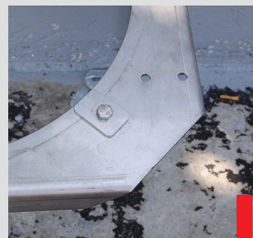
Metallplatten zur Fixierung 3 des JGS- Spülschachtes
