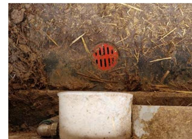
Unmittelbar vor der Wassertränke ist die in der Bodenplatte einbetonierte Funke JGS®-Rinne in einem Abstand von ca. einem Meter mit Rinnenabläufen ausgestattet, die mit roten geschlitzten Rinnenablaufdeckeln verschlossen sind (oben).
